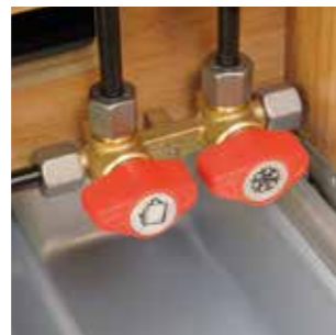
Alle hoofdgas-kranen op één plaats
